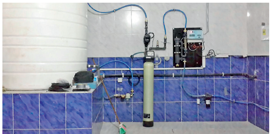
Abbildung 2: Pilotanlage in Niederfrauendorf zur solarbetriebenen Entarsenierung © Autarcon GmbH
